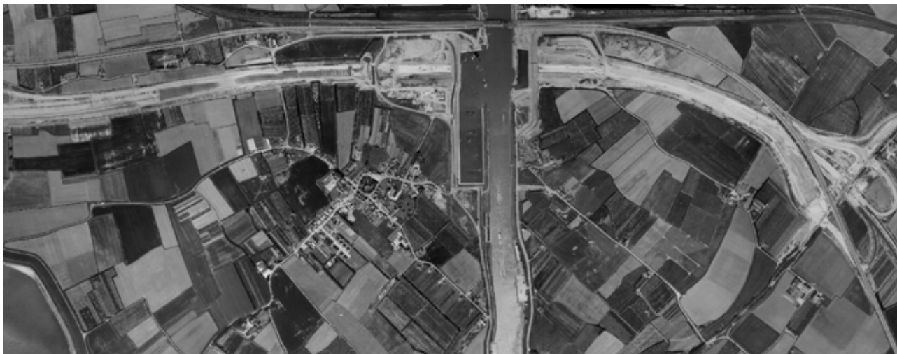
● Schore 1970, aanleg A58 en Vlaketunnel
